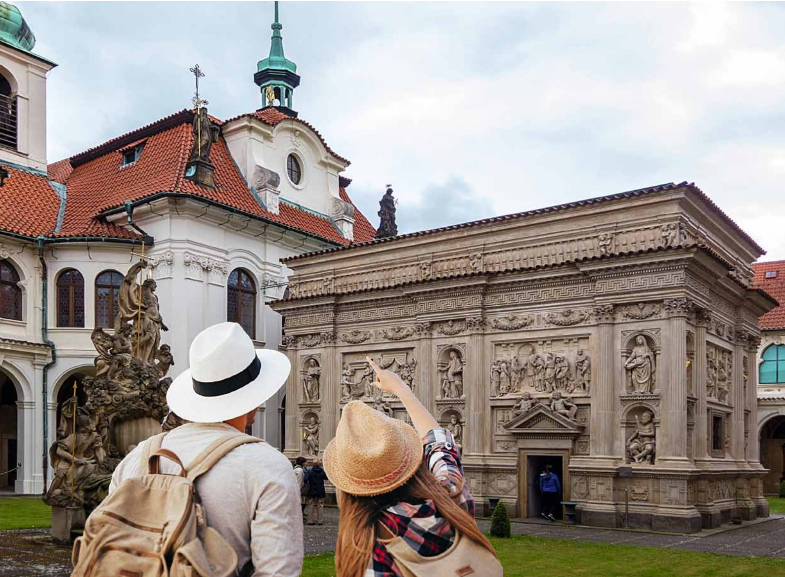
Loretánská kaple v centru areálu poutního místa Loreta při kapucínském klášteře v blízkosti Pražského hradu. Jedná se o kopii tzv. Svaté chýšě z Nazareta (Santa Casa) – originál byl ve Svaté zemi rozebrán a časem převezen do italského Loreta, kde byl znovu postaven
